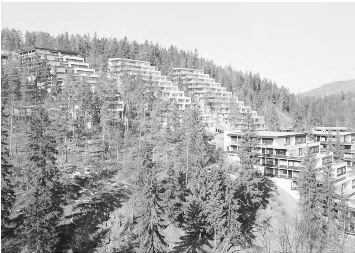
Øvre Ullern terrasse. Ullernåsen project. Source: Teigens Fotoatelier.
