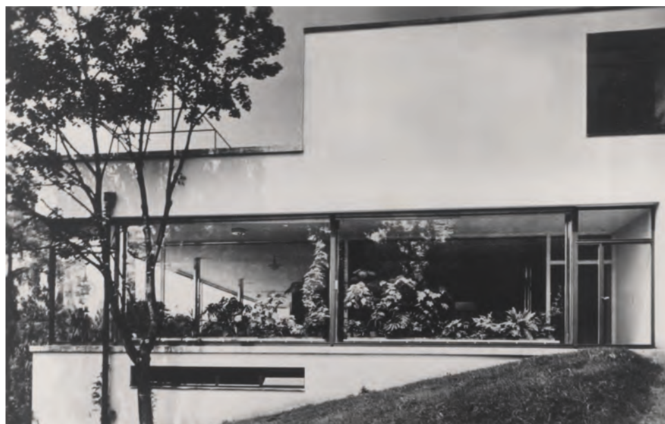
Ludvig Mies van der Rohe, Villa Tugendhat , Brno. Fasade mot øst med vinterhage / View of the eastside towards the winter garden. Foto / Photo: Rudolf de Sandalo (MuMB-ODAU), 1930.
