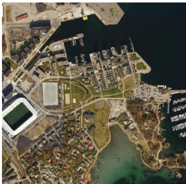
Jåttåvågen, eksempel på transformasjonsområde
